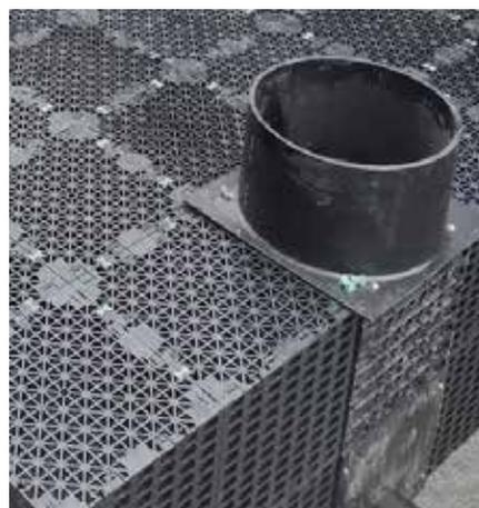
Die ENREGIS X-Box und ENREGIS Controlbox bilden als einzigartig und abmessungsflexibles, hochbelastbares System von Kunststoffhohlkörpern DEN Massstab für Rigolensysteme.
